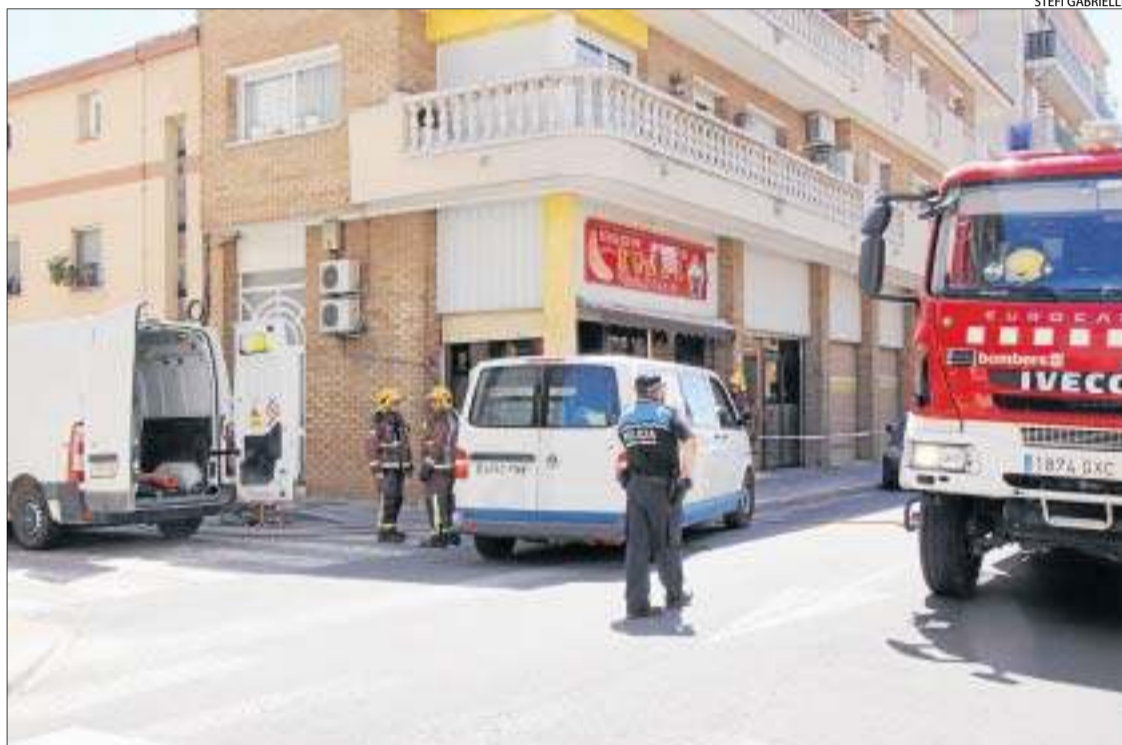
Bombers, Urbana i operaris de Gas Natural, ahir, treballant a la zona de la fuga de gas.
