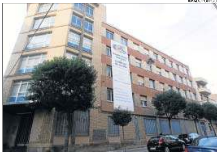
Imatge de la façana de l'edifici del Seminari.
